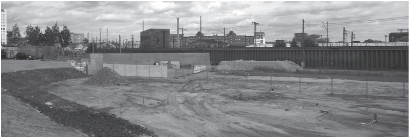
Blick auf den Gedenkort, rechts vor dem Sandwall, und den Baufortschritt der „Fuge“, Zustand 10. Juli 2016, Foto: Moritz Terfloth.
